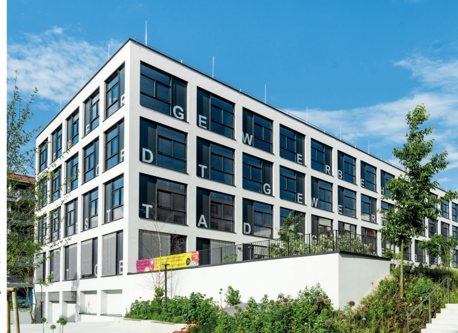
Der Gewerbehof Seestadt ist bewusst in das Wohngebiet hineingeplant
