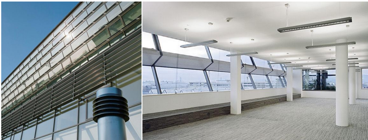
Die gefaltete Fassade erhöht die Photovoltaik-Fläche.
